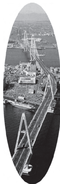
名古屋港の物流を支える 名港トリトン
