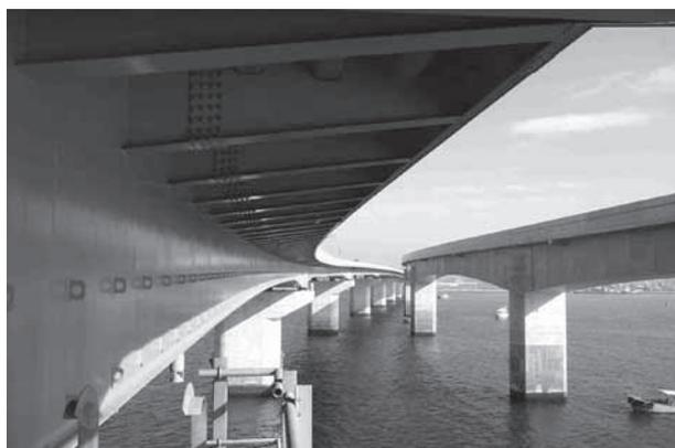
中部国際空港から望むセントレア大橋（鋼床版鋼箱桁橋）
